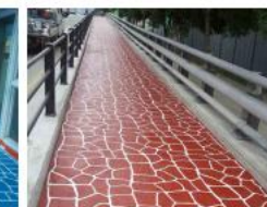
京畿道富川站立交橋
